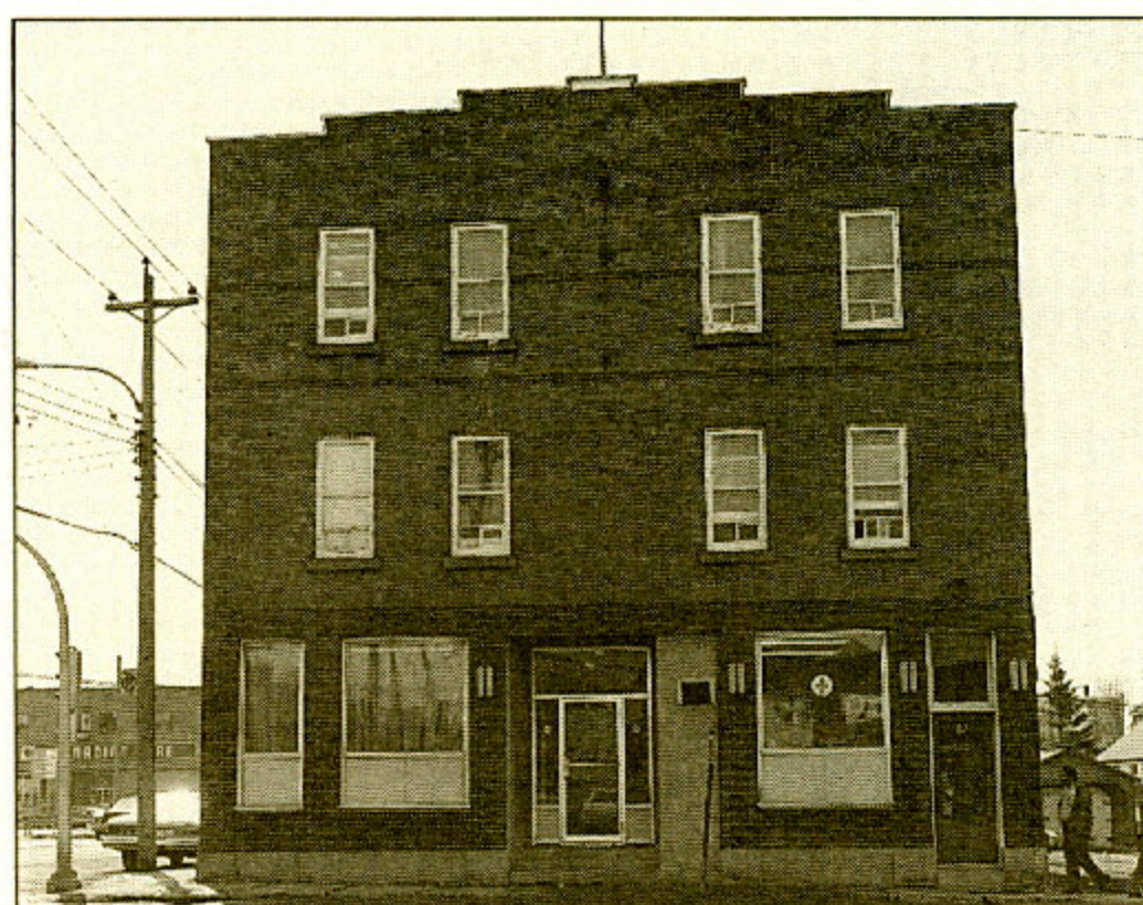
Quartier général du district de l'Abitibi-Témiscamingue et du Nouveau-Québec, abritant le poste de Rouyn, occupé par la Sûreté du Québec de 1968 à 1978.
