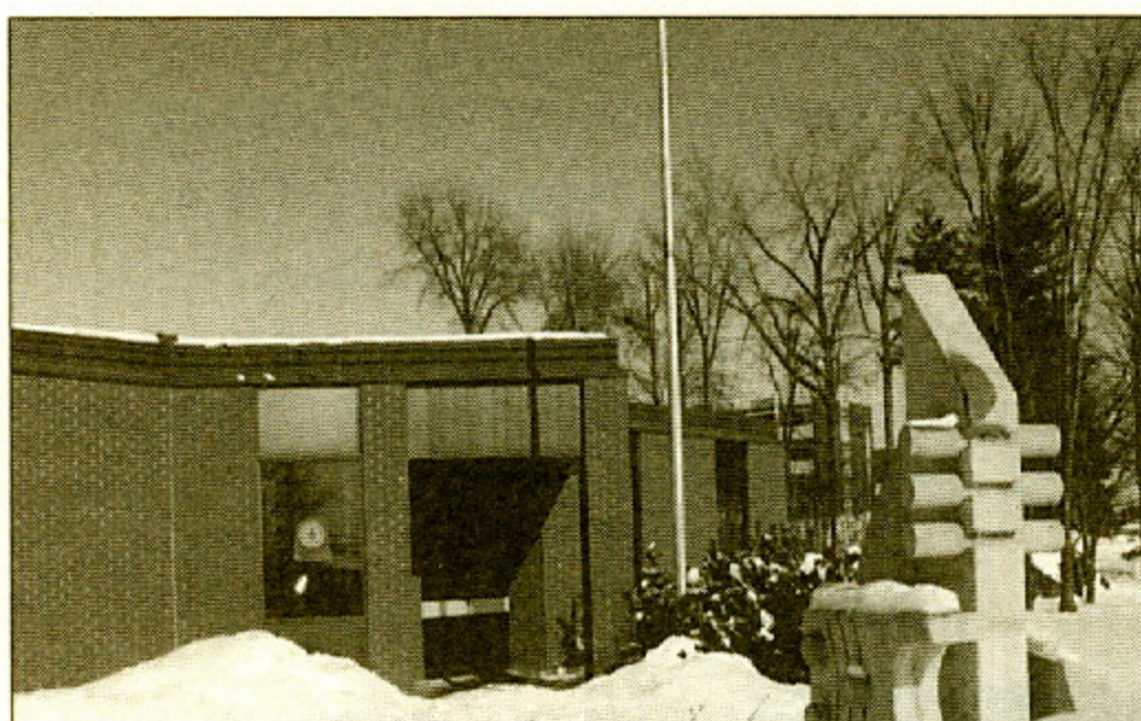
Poste de Papineauville (Outaouais), 1992.
